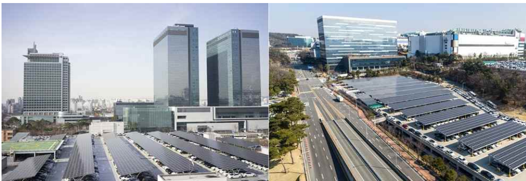
▲ 삼성전자 수원, 기흥사업장 주차장에 설치된 태양광 발전 패널 모습
