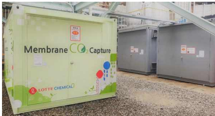
▲ 여수 1공장 CCUS 실증설비 제어실(왼쪽 녹색)과 전처리, 분리 설비(오른쪽 회색)
